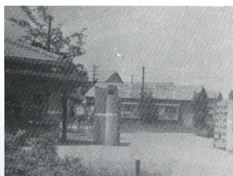
戦火で2階建て事務所が 焼けた跡の正面写真
